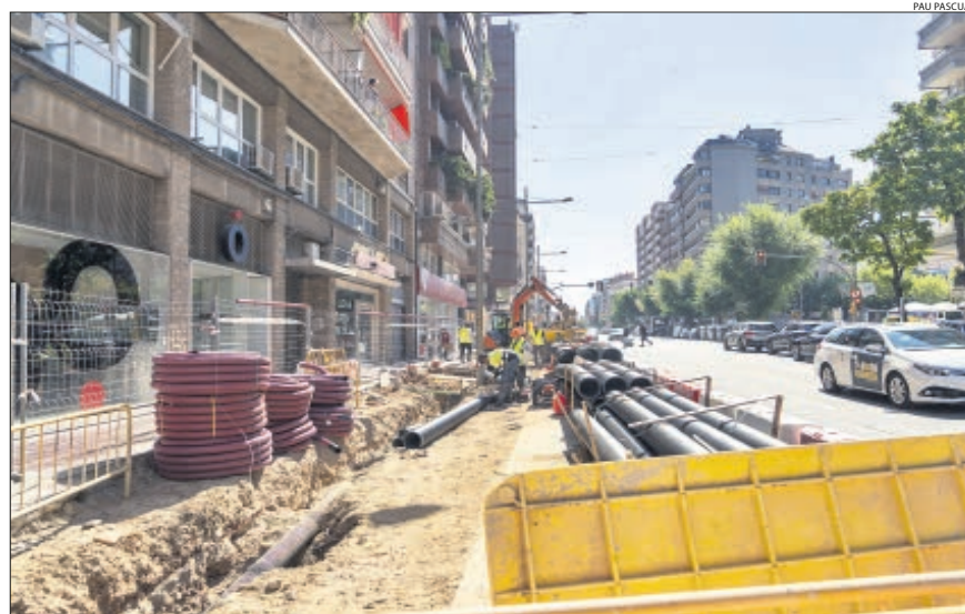
Foto de archivo de las obras que hay en marcha para renovar la red de tuberías en Rovira Roure.
