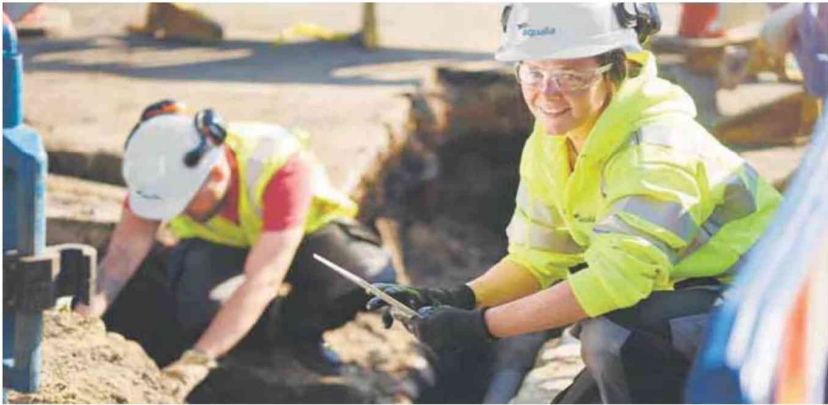
Trabajadores de Aqualia usando tecnología innovadora en una obra.
